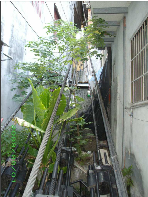
照片 4：鋼纜穿越建物至後方與墩座連結
